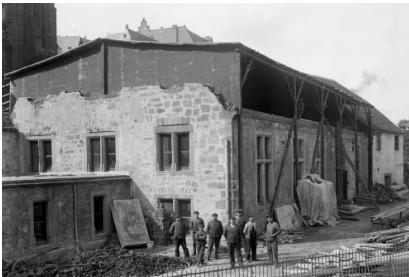
Die Alte Herrenmühle nach dem Brand mit Notdach auf dem Ostflügel
