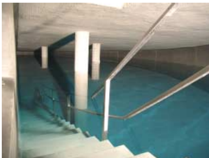
Innenansicht eines Wasserbehälters
