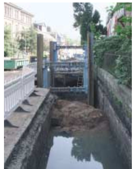
Bauarbeiten in der Ketzlerbach
