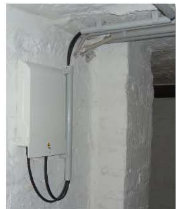
Abbildung 6 Verlegung zum Anschlusskasten (HÜP)
