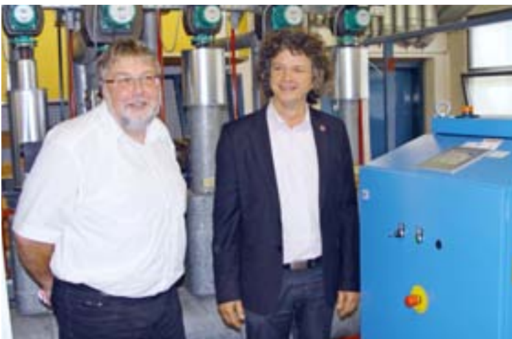
Geschäftsführer Rainer Kühne und Bürgermeister Dr. Franz Kahle nahmen das neue Blockheizkraftwerk der Stadtwerke in Betrieb.
